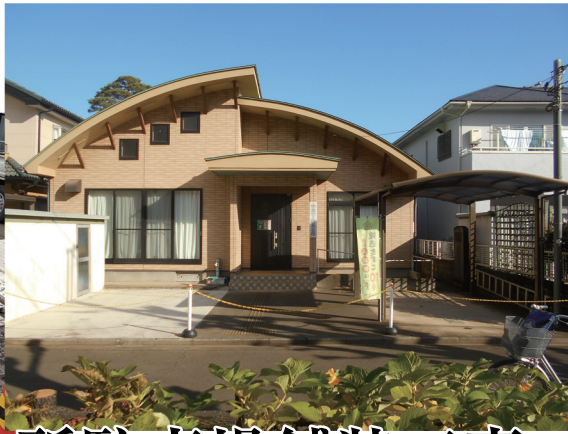
集会所駐車場舗装工事 5月16・17日
